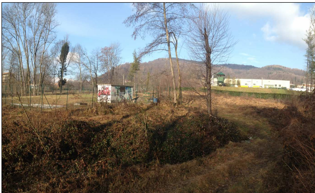
Vista da Sud-Est con in evidenza le infrastrutture dell'impianto di depurazione
